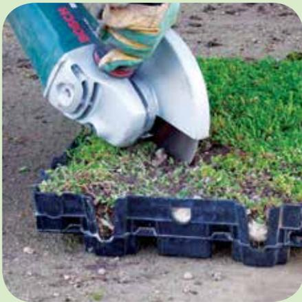
El sistema de bandejas puede adaptarse a la forma de la cubierta
